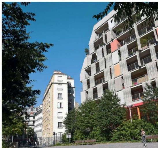
L'arrivée imminente de la ligne 14, sous le parc Martin-Luther-King, va soutenir la cote près de la rue Cardinet.
